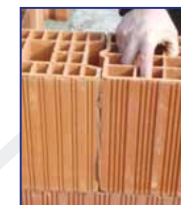
Mortier Joint Mince Mortier déposé au rouleau applicateur ou à la truelle
