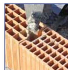
Cas où le joint doit-être réalisé.
