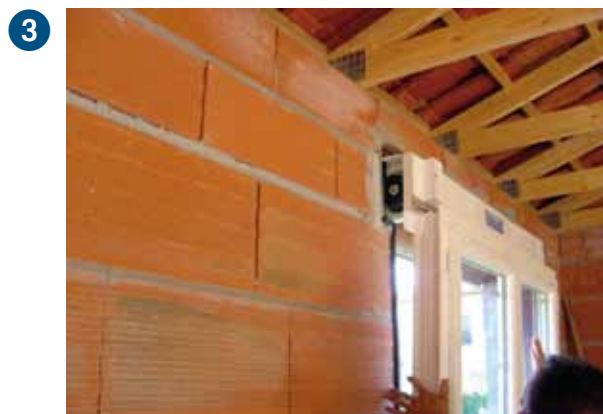
Positionner la menuiserie.
